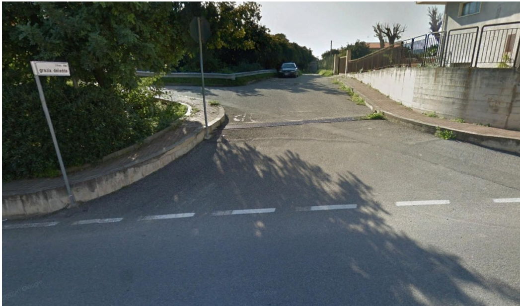
1) Tratto Iniziale I° Trav. Via G. Deledda
