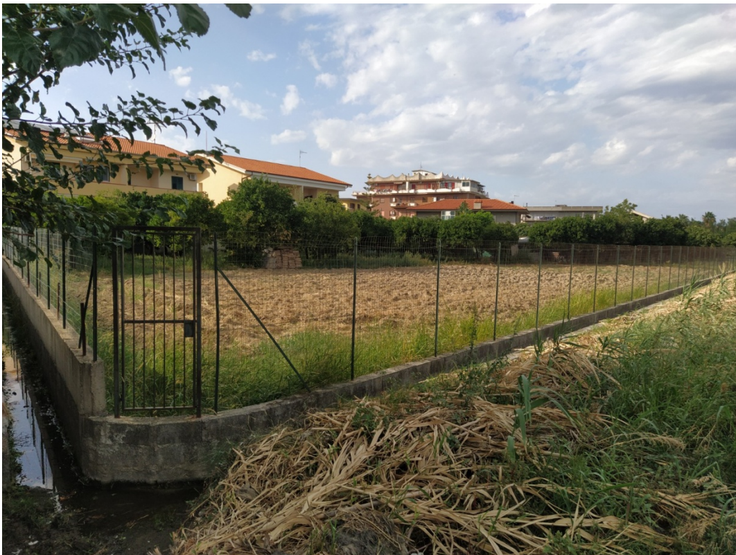
6) Vista sud Area d'intervento
